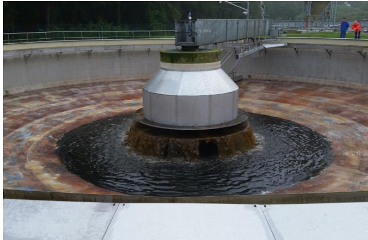
Nachklärbecken mit optimiertem Zulauf
